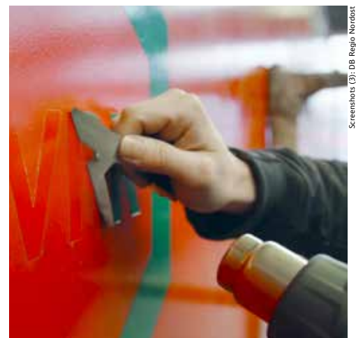
Für die Runderneuerung müssen zum Beispiel auch alte Schriften entfernt werden.
